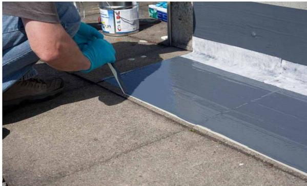
Fertigstellen der Erstbeschichtung durch Entfernen der Abdeckbänder, innerhalb der Verarbeitungszeit von Gomastit Aqua Protect Flex liquid.
