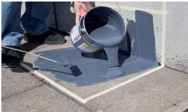
Das Auftragen von Gomastit Aqua Protect Flex liquid erfolgt entweder direkt aus dem Gebinde oder durch Entnahme mit Roller, Pinsel oder Spachtel. Hierbei muss aber beachtet werden, dass kein Schmutz ins Gebinde gelangt.
