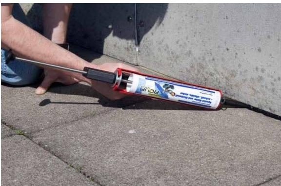
Gomastit Aqua Protect Flex mit einem Spachtel glatt abziehen, kein Abglättmittel verwenden, da dieses die Haftung zwischen Gomastit Aqua Protect Flex und Gomastit Aqua Protect Flex liquid negativ beeinträchtigen kann.
